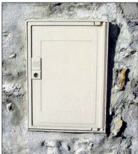
Figure 2 : Exemple de coffret de raccordement au réseau
